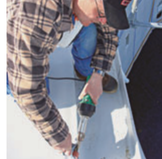
TRIAC PID: Profesionální ruční přístroj pro svařování na střeše.
