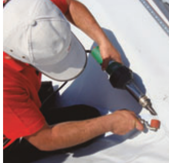
Navařování záplaty na staveništi s přístrojem TRIAC PID.
